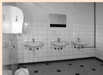
Toalety na chodbě u recepcce
